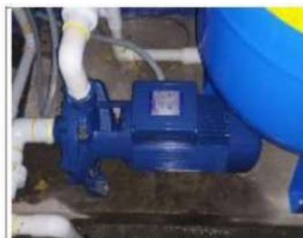
Instalación de bomba
