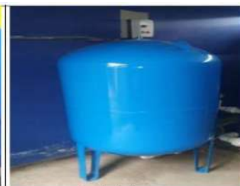
Instalación de tanque
