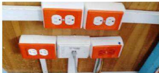
Ilustración 15. Cambio de cojinetes y tomacorrientes.
